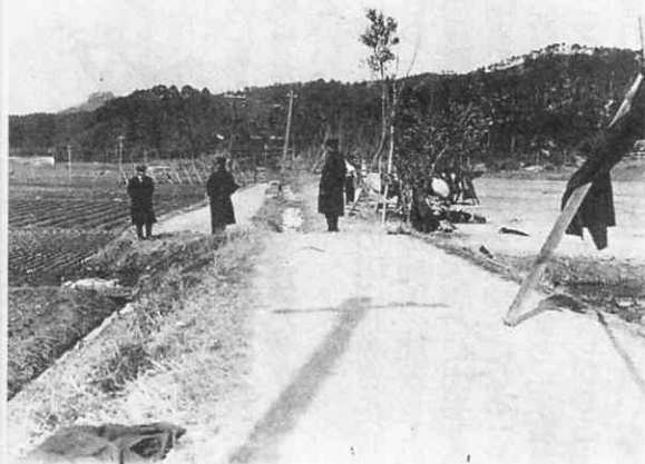
北丹後地震によってずれた道路を記録した写真ガラス乾板
